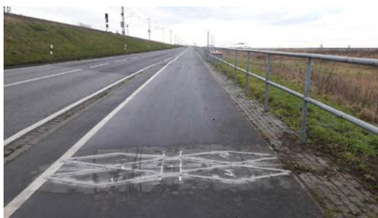
An 16 stationären Zählstellen, wie hier auf Rügen, werden seit Dezember 2019 Radfahrer gezählt. Ergänzend kommen mobile Zähler an insgesamt 57 Standorten zum Einsatz.
