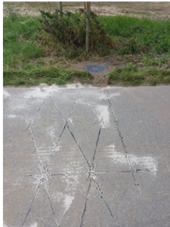
Beispiel eines Zählgerätes mittels Induktionsschleife
