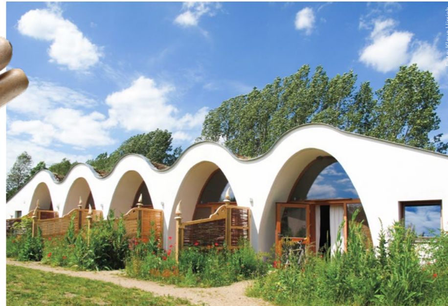
Die ökologisch nachhaltigen Lehmbauten im Wangeliner Garten sorgen ganzjährig für ein gesundes Wohnklima.
